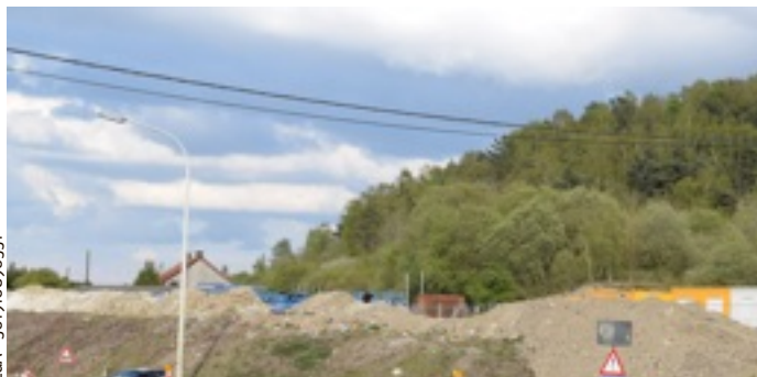
Le terrain, exproprié, est proche de la ligne 134 et de la future E420. En chantier, il appartient à la Région.
